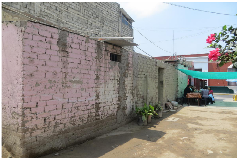
Figura 3. Problema: la tenencia de viviendas.
