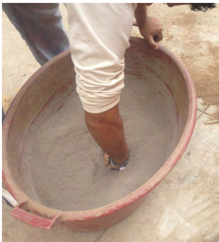
Figura 9. Mezcla del suelo y el cemento
