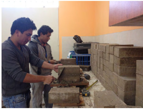
Figura 22. Verificando el grosor de la junta horizontal
