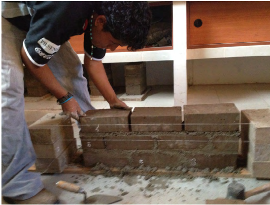
Figura 24. Asentando las unidades de albañilería antes de su nivelación
