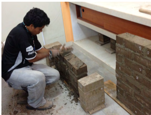
Figura 25. Rellenando las juntas verticales
