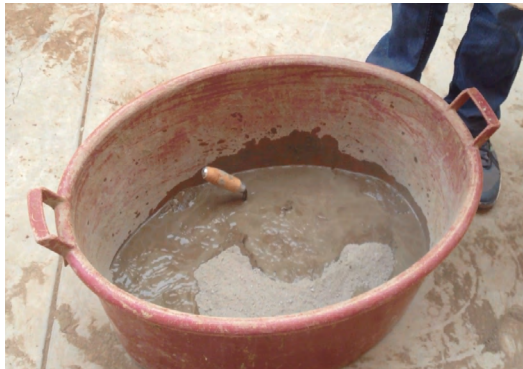
Figura 11. Adición del agua a la mezcla
