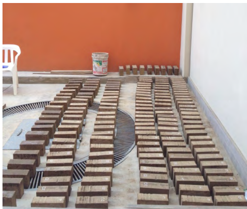
Figura 15. Curado y acopio de las unidades
