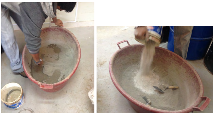
Figura 20. Elaboración del mortero 1:1/2:4 (Cemento, Cal y Arena)
