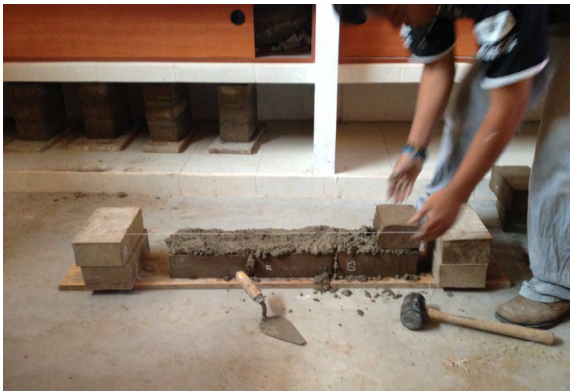
Figura 23. Asentando la media unidad de albañilería en la parte extrema del murete
