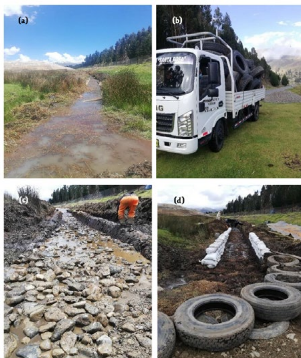
Figura 8. (a) Tramo crítico por afloramiento de agua subterránea. (b) Traslado de llantas de automóviles para reúso. (c) Implementación de un filtro estilo francés. (d) Estabilización del canal con llantas y costales.
