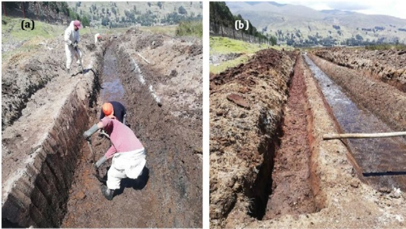
Figura 10. (a) Excavación de canal del humedal. (b) Vista de la zanja de anclaje y perfilado del canal del humedal.
