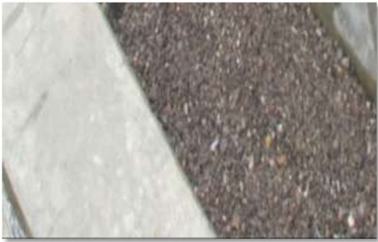
Figura 10. Colocación del estrato final de arena gruesa.
