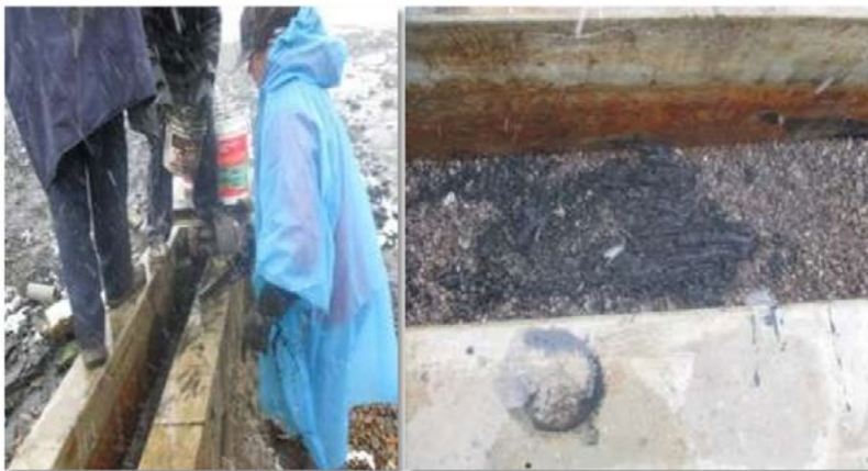
Figura 8. Incorporación de lodo activado enriquecido con nutrientes y consorcios bacterianos sulfato-reductores.
