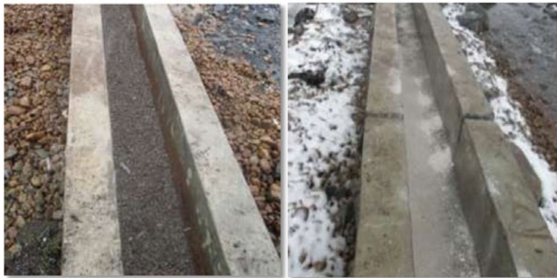
Figura 7. Instalación del material calcáreo en el sistema.
