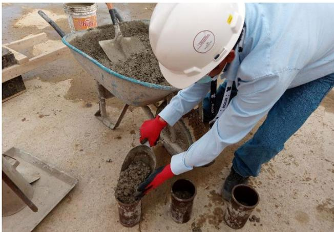
Figura 15. Dosificación de cultivo bacteriano en mezcla de concreto
