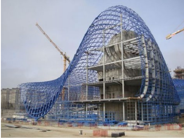
Figura 1. Centro Heydar Aliev. Estructura. Arquitecta: Zaha Hadid
