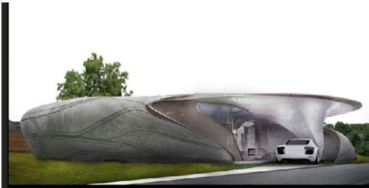
Figura 7. Casa impresa en 3D, WATG arquitectos, Chattanooga, TN, Estados Unidos.
