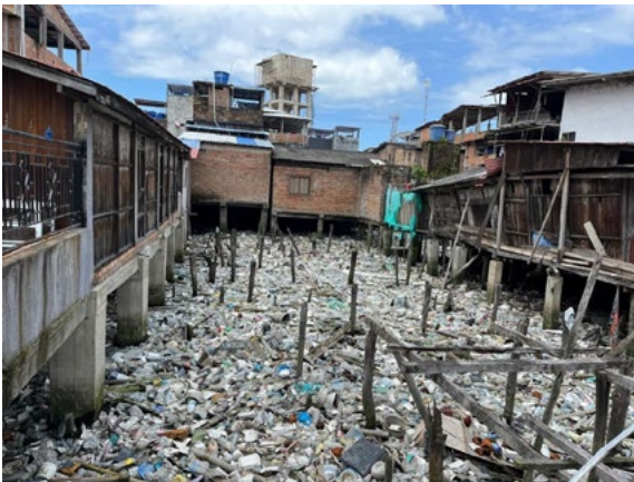
Figura 1. Puente peatonal, barrio el progreso, municipio de San Andrés de Tumaco (Nariño). Nota: elaboración propia.
