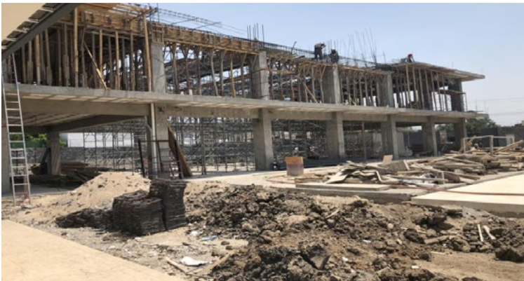
Figura 8. Estructura de concreto y cimbra para losa.
