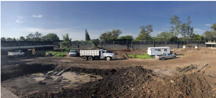
Figura 7. Material producto de excavación.
