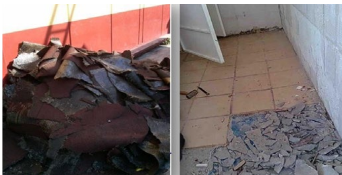
Figura 10. Residuo de impermeabilizante prefabricado, retiro de loseta cerámica y cementante.
