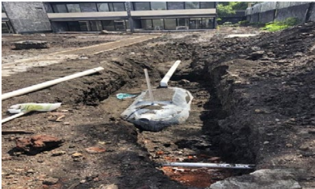
Figura 9. Instalación de tanque de oxidación.
