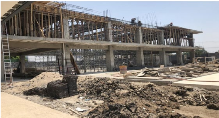
Figura 8. Estructura de concreto y cimbra para losa.
