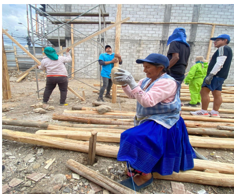
Figura 2. Socia fundadora de 76 años sentando las bases, mientras el resto de compañeros participan de la minga de construcción del centro de acopio.
