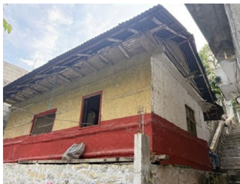
Figura 8. Caso 4. Vivienda de Bajareque a dos aguas, vanos rectangulares, sobre plataforma artificial. Nota: Pedraza (2026).
