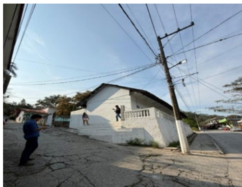
Figura 7.- Caso 3. Vivienda construida sobre plataforma de piedra. Portal hacia la calle. Nota: Castro (2026).
